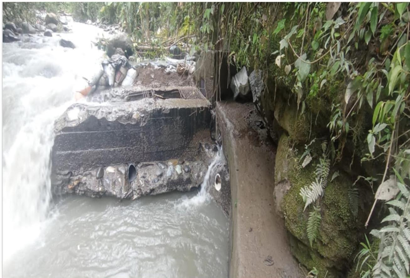
**CONSTRUCCIÓN DE MURO CICLÓPEO, SUMINISTRO E INSTALACIÓN DE REJA DE 4.4
