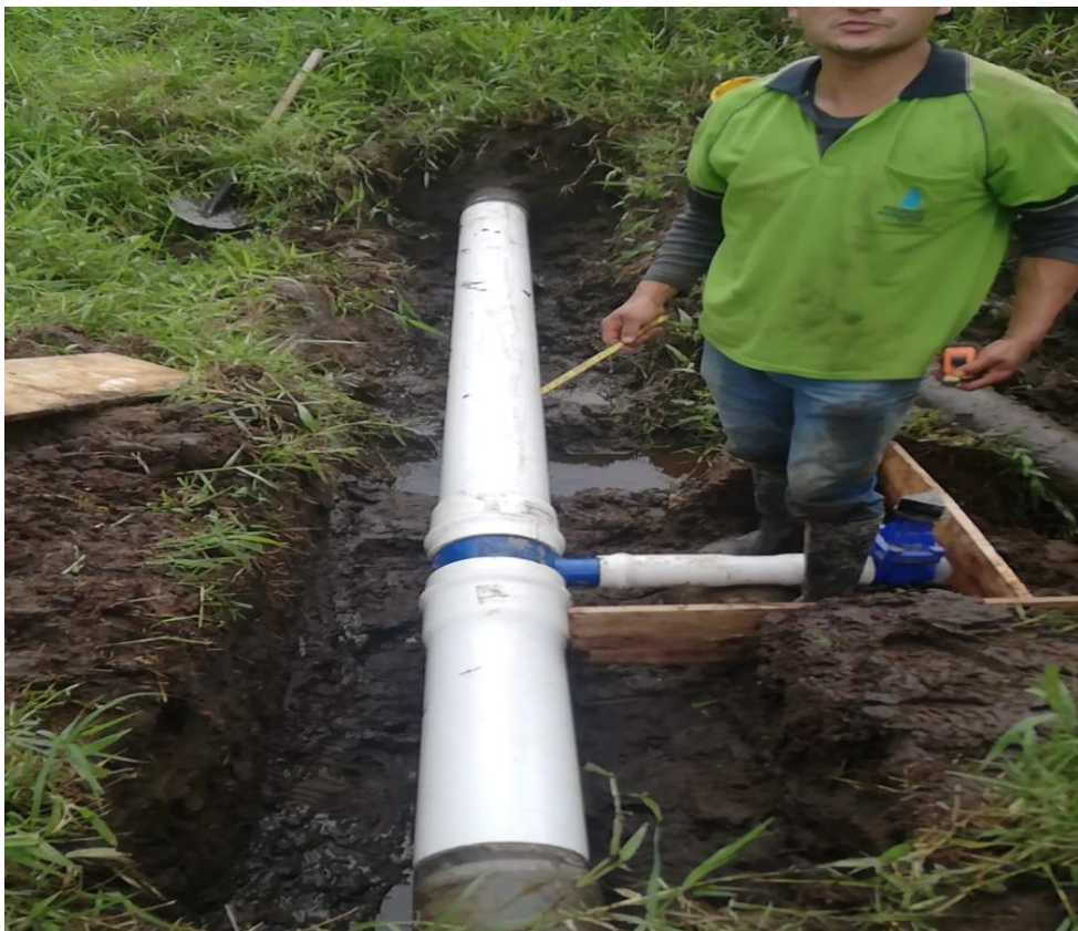
INSTALACIÓN DE UNA VALVULA DE 3" EN LA RED CONDUCCIÓN, EN LA BOCATOMA DEL BRILLANTE, NOVIEMBRE 24 DE 2022.
