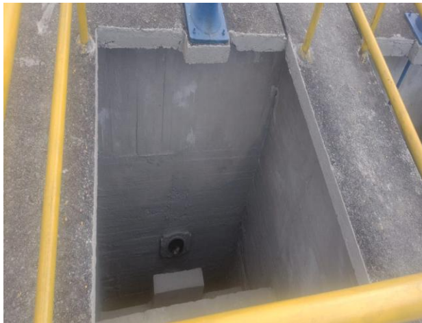
Impermeabilización de infraestructura de la PTAP en sedimentadores y filtros, cambio de válvulas dañadas de la PTAP.
