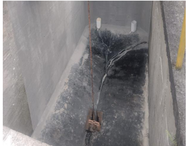
Impermeabilización de infraestructura de la PTAP en sedimentadores y filtros, cambio de válvulas dañadas de la PTAP.
